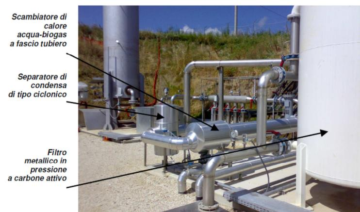
*Scambiatore di calore acqua-biogas a fascio tubiero*
