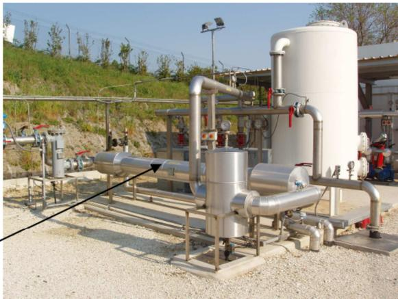
*Scambiatore di calore acqua-biogas a fascio tubiero*
